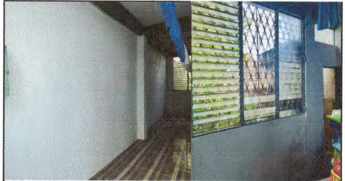
Foto 8: Sustitución de repello de muro en módulos 1 y 2 de aulas.
