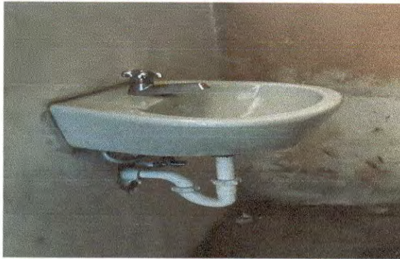
Foto 7: Sustitución de lavamanos en módulo 1 de aula.
