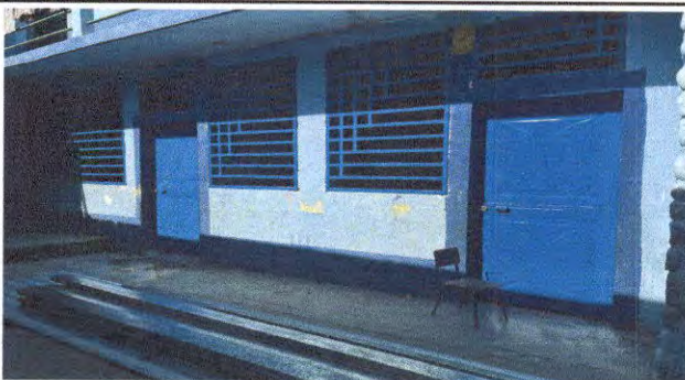
Foto 11: Sustitución de puertas de metal en módulos 1 y 2 de aulas.
