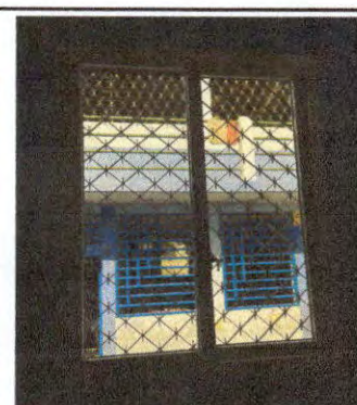
Foto 4: Sustrucción de ventanas de aluminio y vidrio de paletas por estructura de pvc y vidrio corredizo en módulo de dirección.
