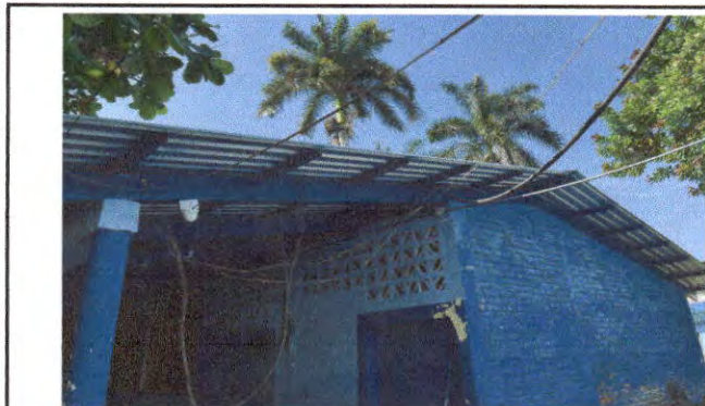
Foto 3: Sustrucción de lámina acanalada, por lámina troquelada aluzinc calibre 26, en módulo de baños.
